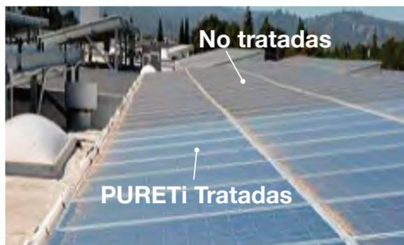
PURETi Clear es un tratamiento de superficies arquitectónicas aplicado en aerosol, a base de agua, activado por luz, que revierte la contaminación.
